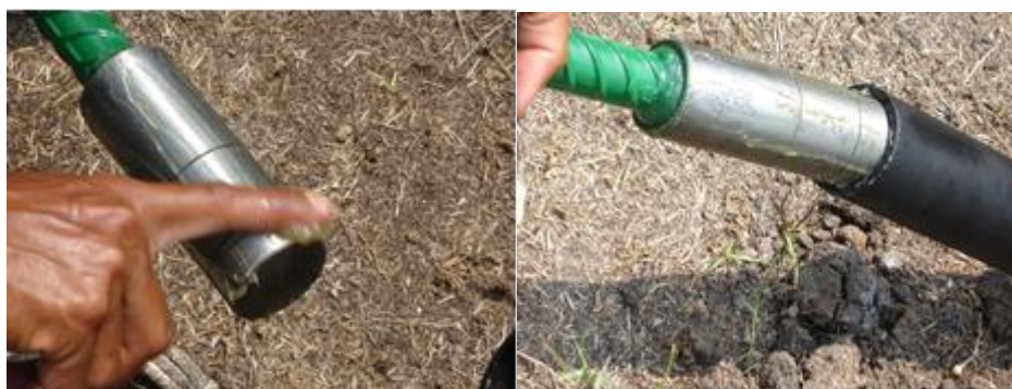
รูปที่ 76 แสดงการทาบารบิบนฐานของลูกตุ้มเหล็กก่อนใส่เข้าไปในท่อยิงตาข่าย
