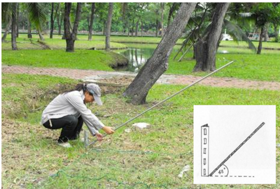
รูปที่ 64 แสดงการตอกเสาลงไปทำมุมกับพื้นดิน 45 องศา
